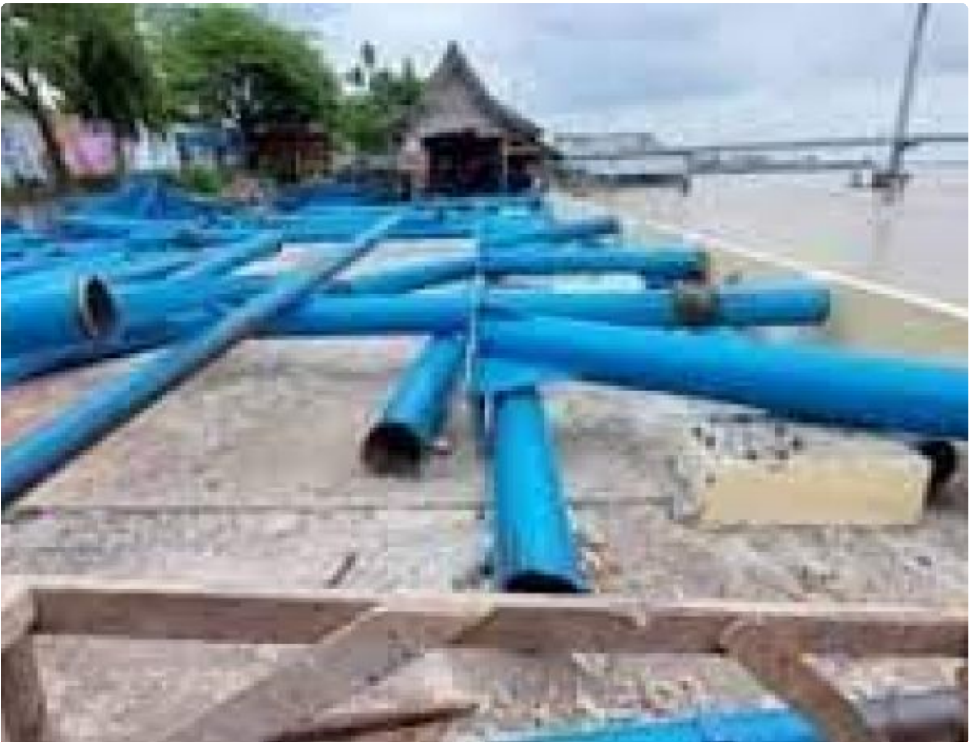
Penampakan kerangka besi bangunan proyek rehabilitasi Tanggo Rajo yang dibongkar/foto: istimewa
